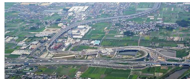
京奈和自動車道、西名阪自動車道周辺
